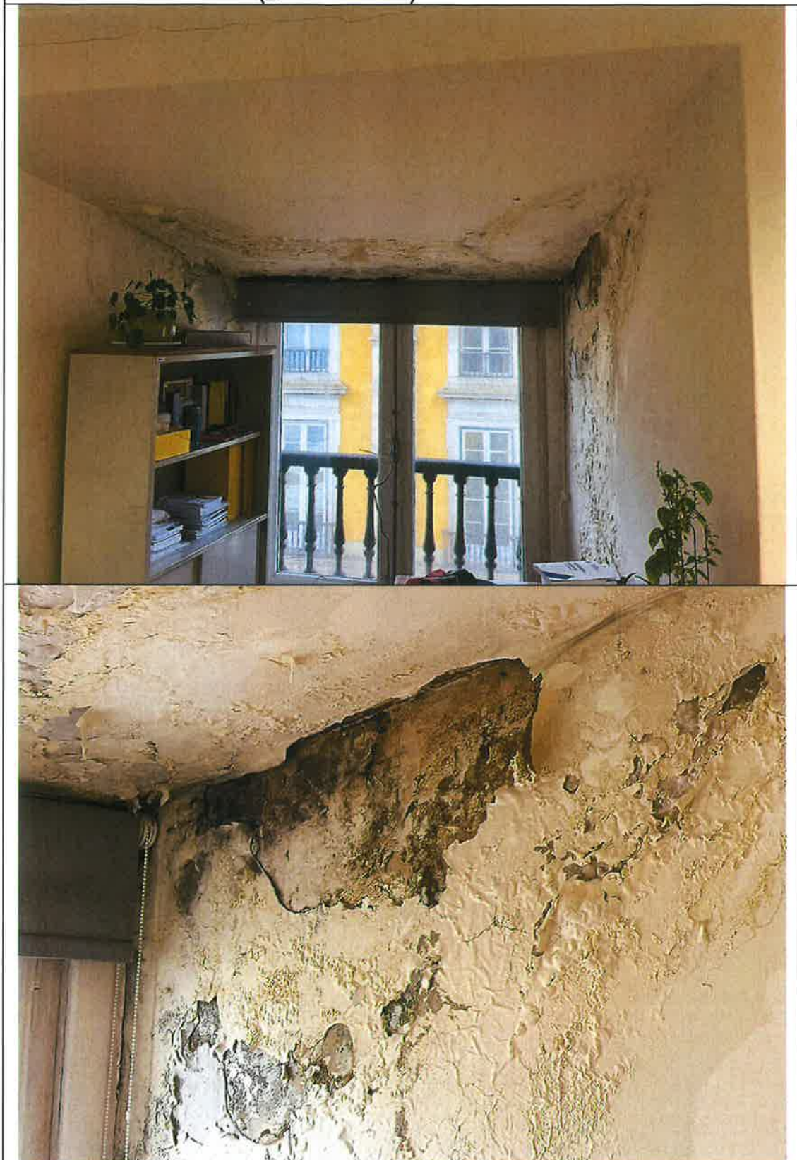
Sala de técnicos da DJEE (2 trabalhadores)
