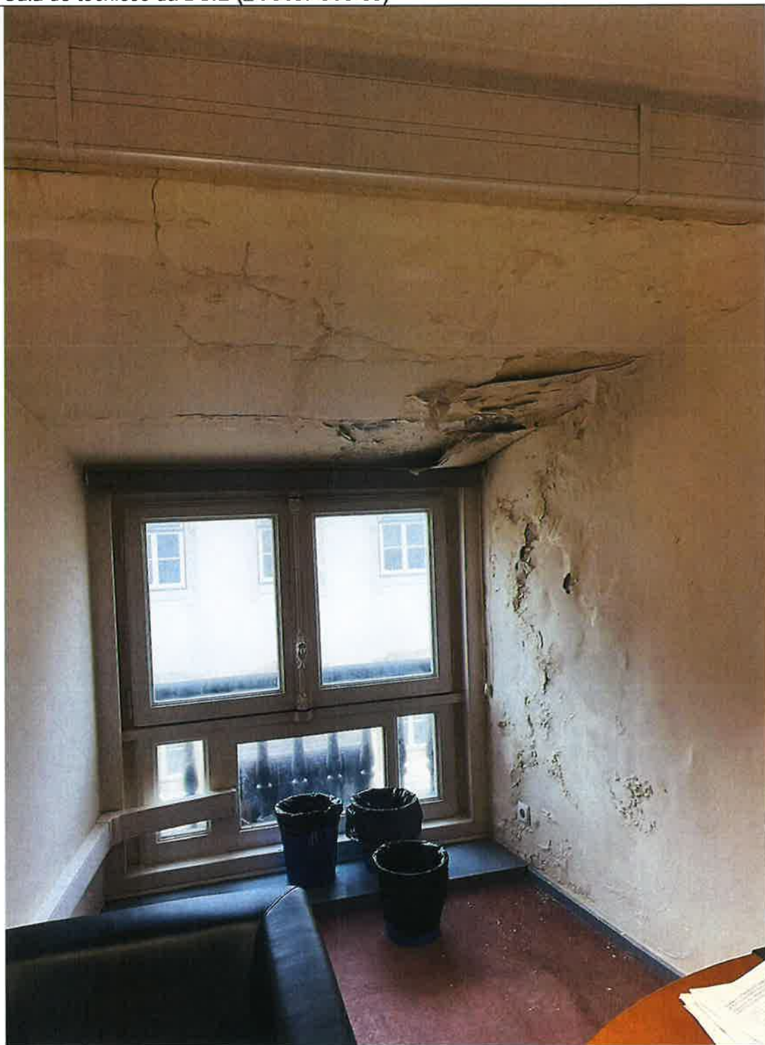
Sala de técnicos da DSIE (2 trabalhadores)
